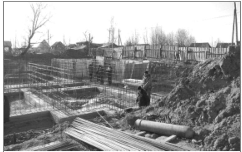
В строительстве нового дома используются современные технологии.
