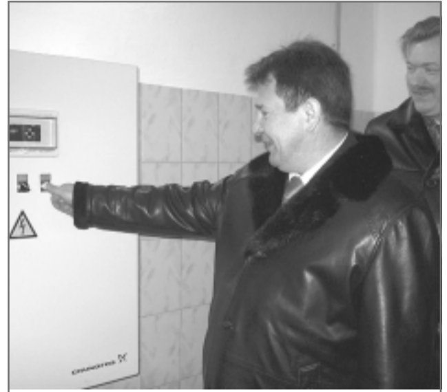
Радостный момент: Александр Пахолков пускает новый водопровод.
